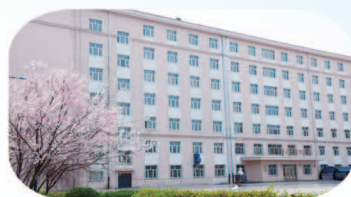
第五教学实训楼
